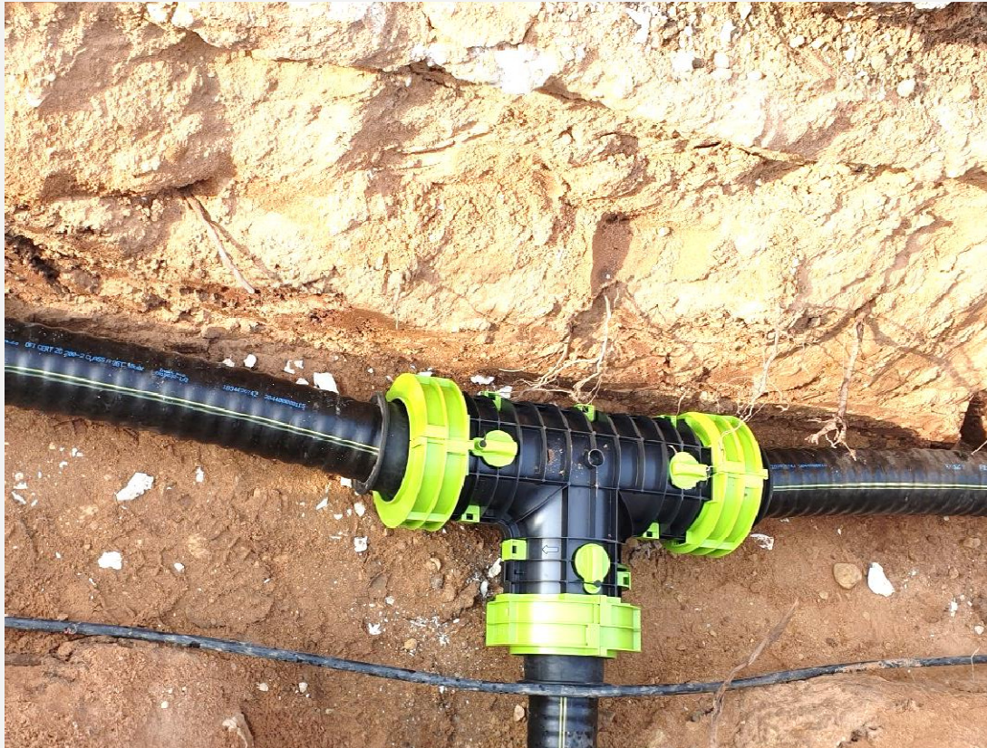
T-Stück im offenen Graben
