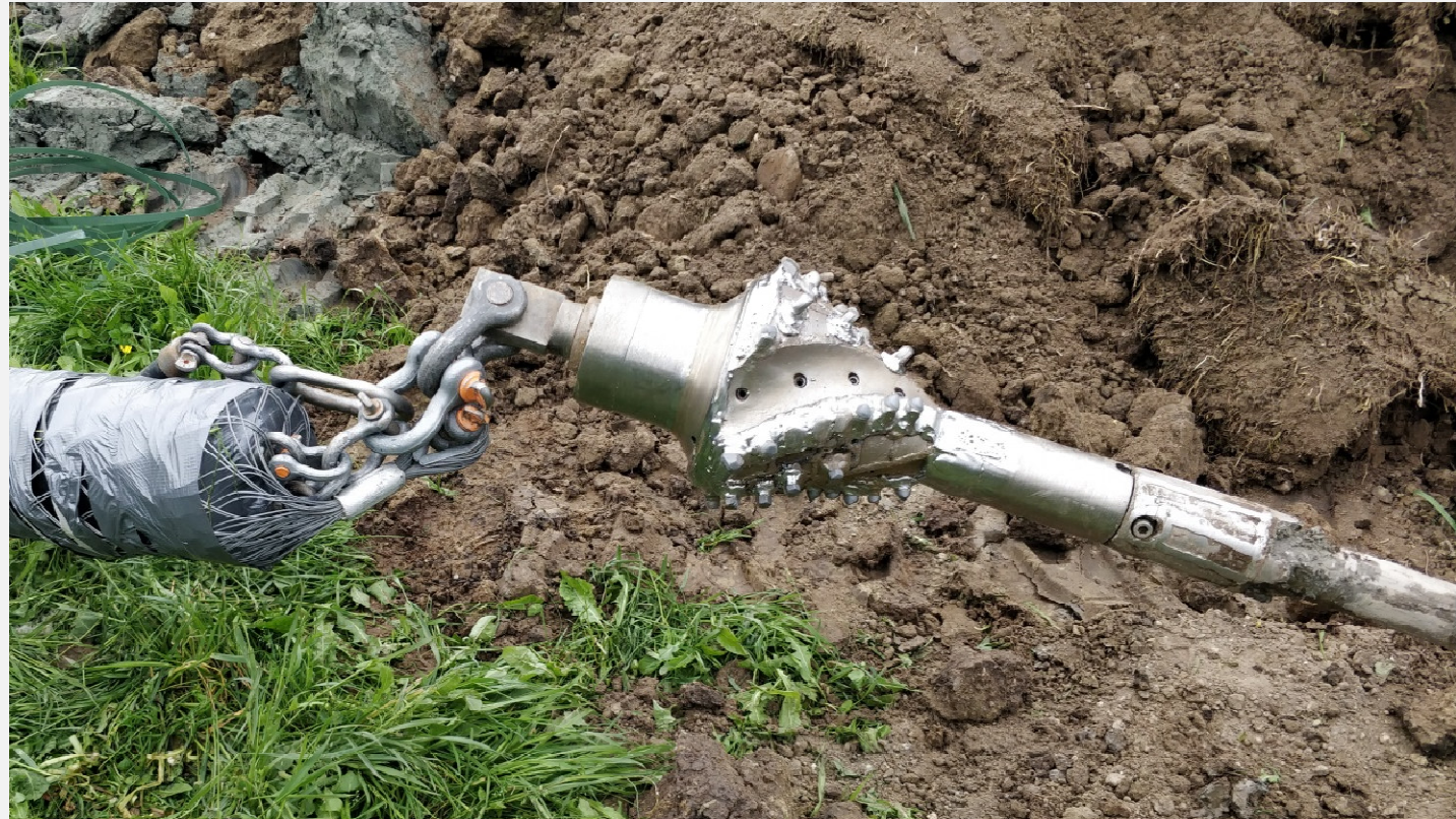
Grabenlose Verlegung im günstigen Spülbohrverfahren
