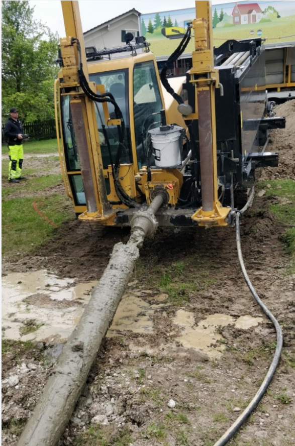
Grabenlose Verlegung im günstigen Spülbohrverfahren
